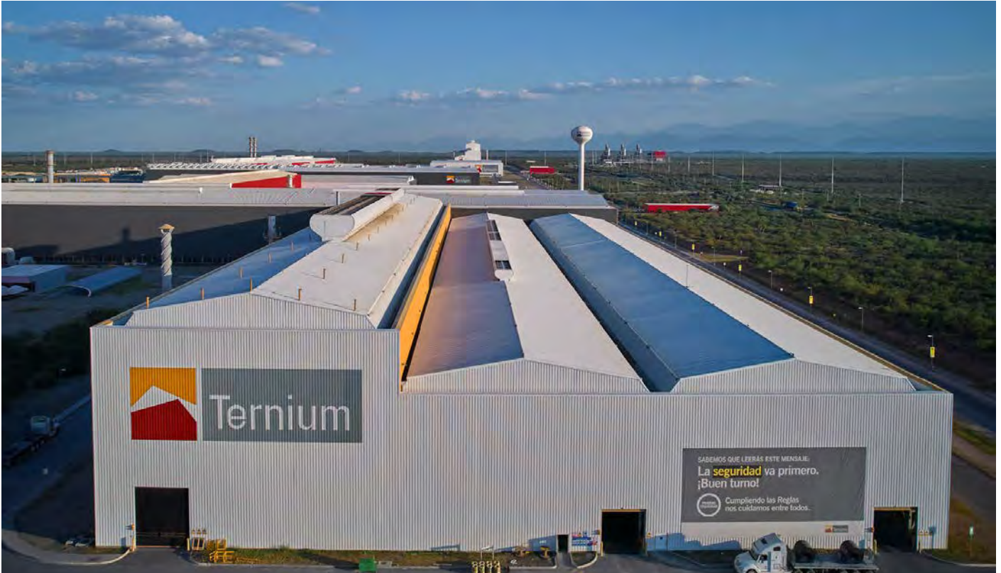
Expansión del Centro Industrial de Pesquería, México. Proyecto anunciado con tecnología DRI-EAF preparada para la captura de CO 2 y el uso de hidrógeno verde.
